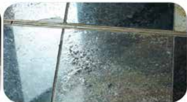
SPALLING
